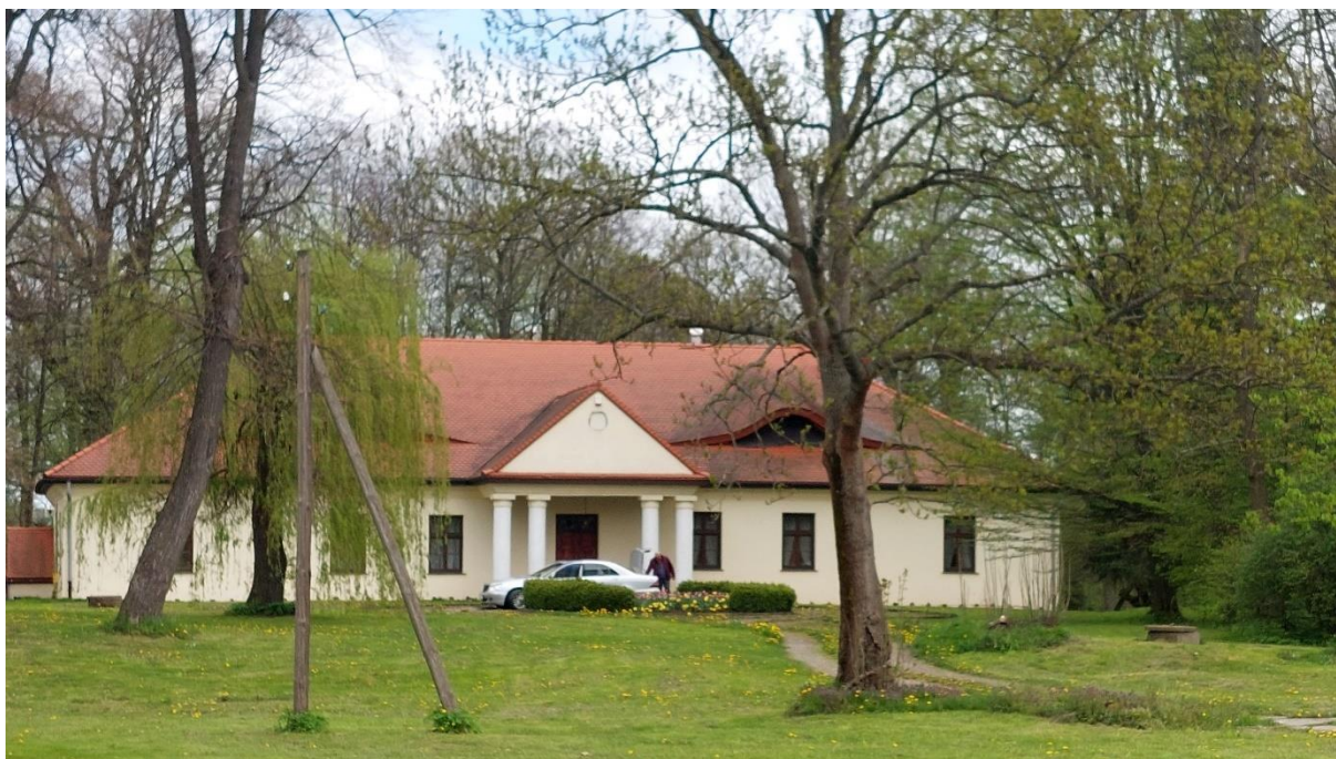
Fot. 8. Łubno Szlacheckie. Dwór (fot. autor opracowania).
