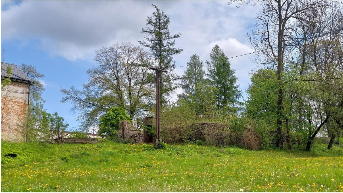
Fot. 10. Tarnowiec. Piwnice starego dworu (fot. autor opracowania).
