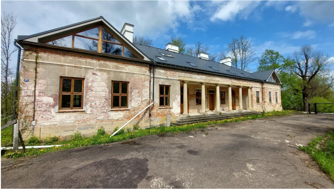
Fot. 9. Tarnowiec. Dwór Pilińskich (fot. autor opracowania).
